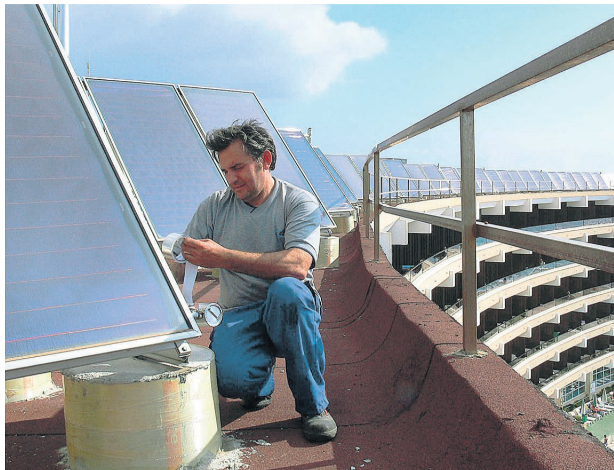
Handwerker installiert Solarthermie-Anlage: Die Branche gehört zu den großen Gewinnern der Energiewende. FOTO: DPA
