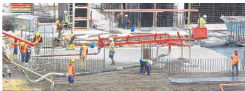
Hier könnte bald schon weit weniger los sein: Die Bauwirtschaft in Baden-Württemberg leidet unter Fachkräftemangel.
