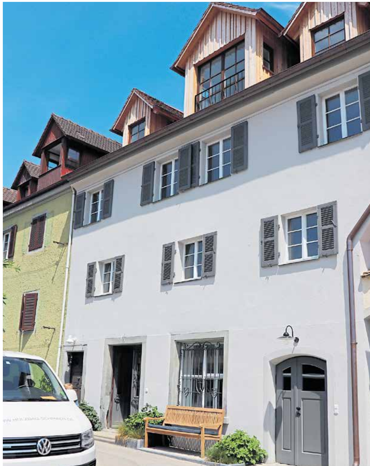
Das barocke Wohnhaus in Meersburg wurde behutsam instandgesetzt.
