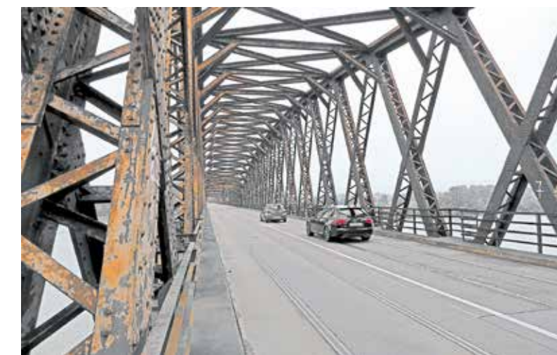
Die Rheinbrücke Wintersdorf: Hier war der Grenzübergang nach Frankreich für Handwerker lange Zeit nicht möglich.
