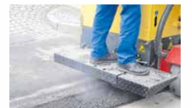
Sorgenkind Straßenbau: Seit Mitte 2020 gehen die Umsätze deutlich zurück. Foto: Bauwirtschaft BW
